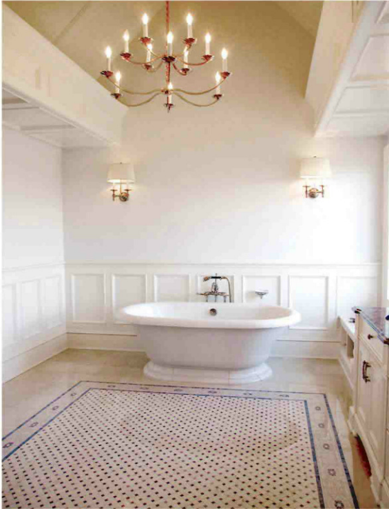
crema marfil basket weave 1 1/4"x2 1/2", blue bahia dot 5/8". crema marfil 12"x12", 8" alin border
